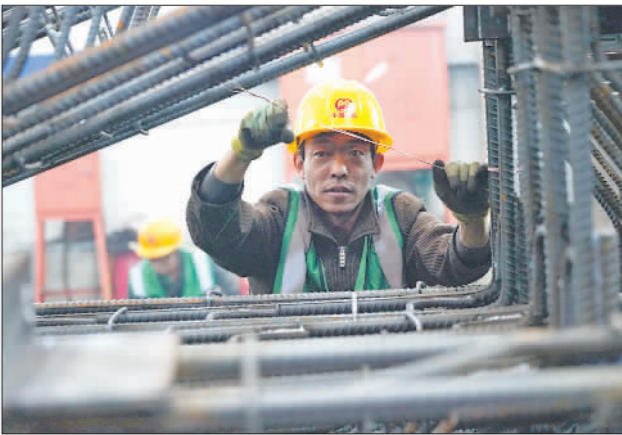
10月5日,北京地铁19号线牡丹园站施工现场,中铁七局工作人员坚守岗位,紧张施工。由中铁七局承建的北京地铁19号线牡丹园站及两端区间土建施工部分,已进入主体结构最后攻坚阶段。李欣摄
