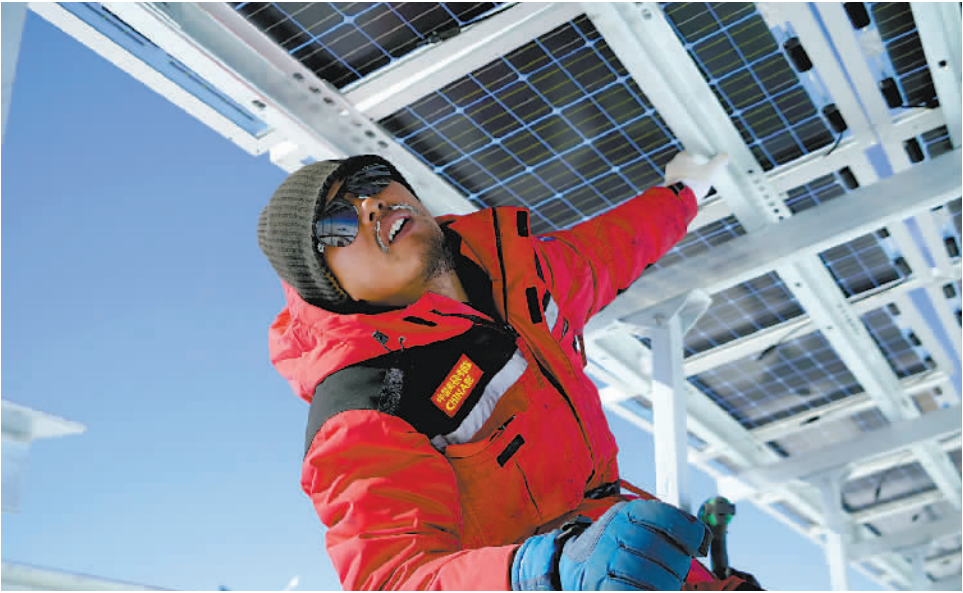
曾应根为泰山站新能源系统安装光伏太阳能板。
