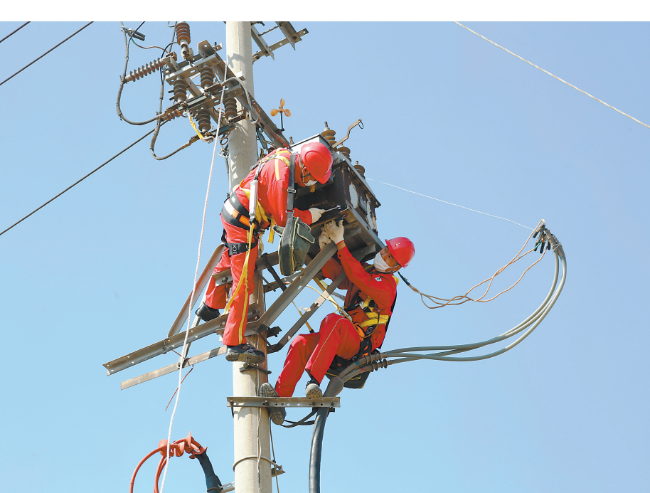
4月26日，在河北唐山曹妃甸，中国石油冀东油田电网春季检修正在进行中，电力检修工像蜘蛛侠一样在铁塔上争分夺秒地忙碌着。 图为两名工人正在线杆上加装占位器。 杨军 张猛 摄
