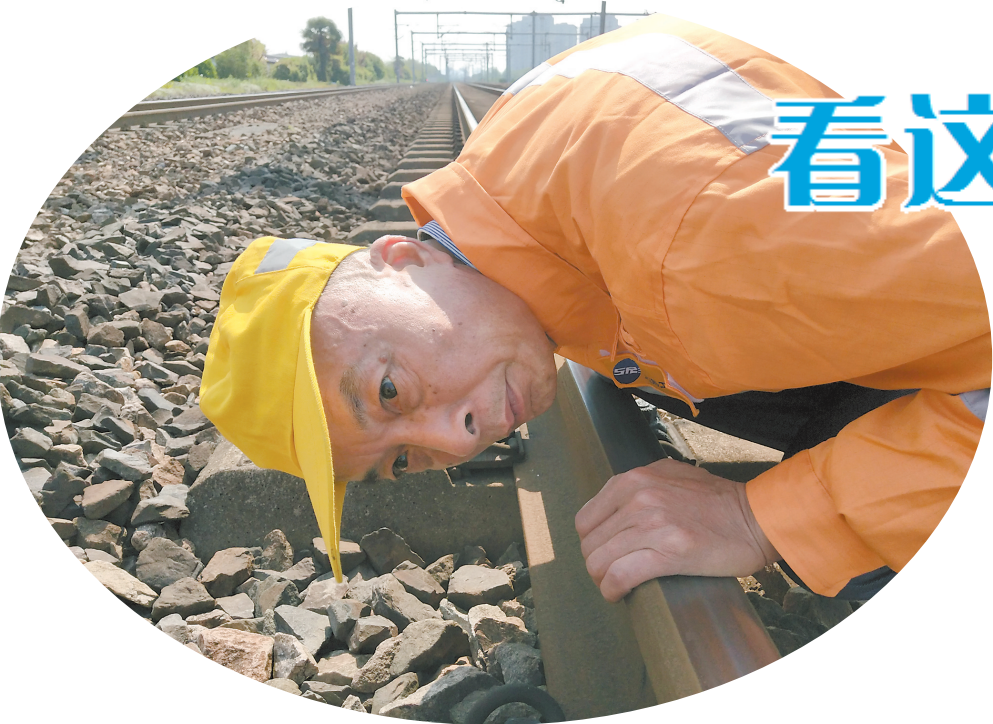
接近耳顺之年的松江线路车间副主任蒋钱明一直保持着这样的工作习惯——现场测量亲自上手，所有数据必须测量3遍以上。 图为4月23日，蒋钱明在沪昆线查看线路高低、平顺度。 沈东平 摄
