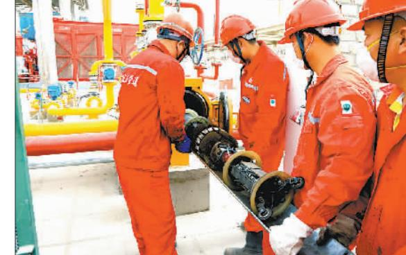
近日,中国石化西北油田油气运销部连续开展油气长输管道清管作业,引入管道内检测、新型清管器远程监测仪等新技术、新设备,在提高清管质量和效率的同时,有效提升管输效率、降低运行能耗,全力保障油田动脉高效畅通。
