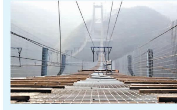
疫情期间,云南红河特大桥工程下部结构施工基本完成,全面启动上部结构工程建设。该桥是云南建水(个旧)至元阳高速公路(建水至元阳段)控制性工程,于2017年11月开工建设。大桥全长1366米,桥面宽25.5米,主跨700米,为悬索桥结构,库区水面距桥面高188.4米。
