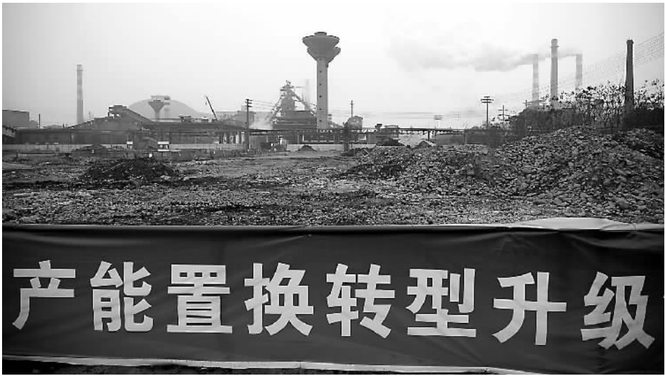
陕西汉中钢铁集团有限公司内被拆除的1号高炉所在地,这里将建设工艺更先进的75吨电弧炉,降低污染物排放的同时减少炼钢用水。
