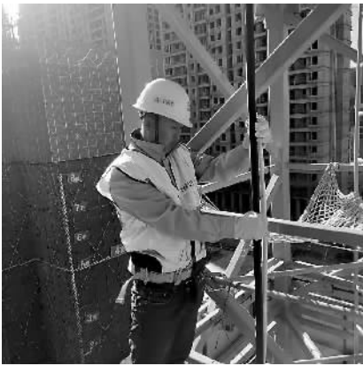
梁淮南在做日常的塔吊检查,并检查电缆是否存在安全隐患。
