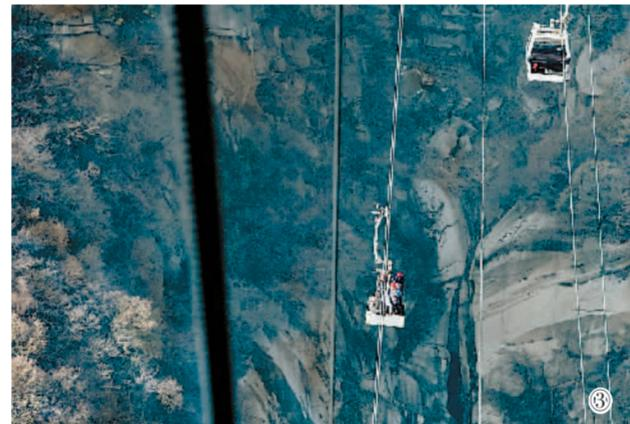
图① 华山太华索道维修人员在进行索道支架横担检测(12月5日摄)。
