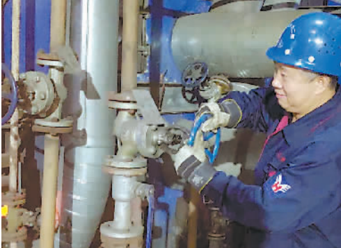
司炉工杜营光正在对锅炉进行排污操作。
