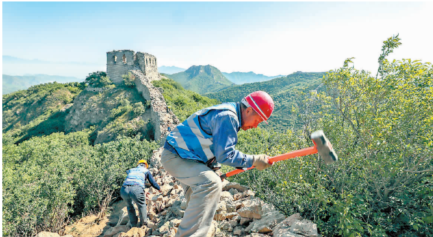
北京昌平,工人正在修复长城。
