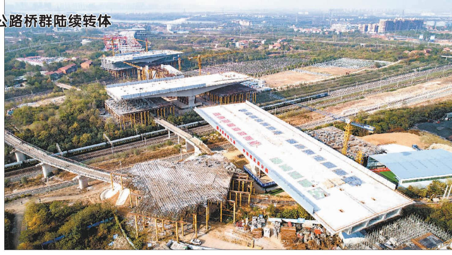
11月7日，武汉市北四环跨铁路工程项目2号墩转体桥顺利完成转体(无人机拍摄)。
