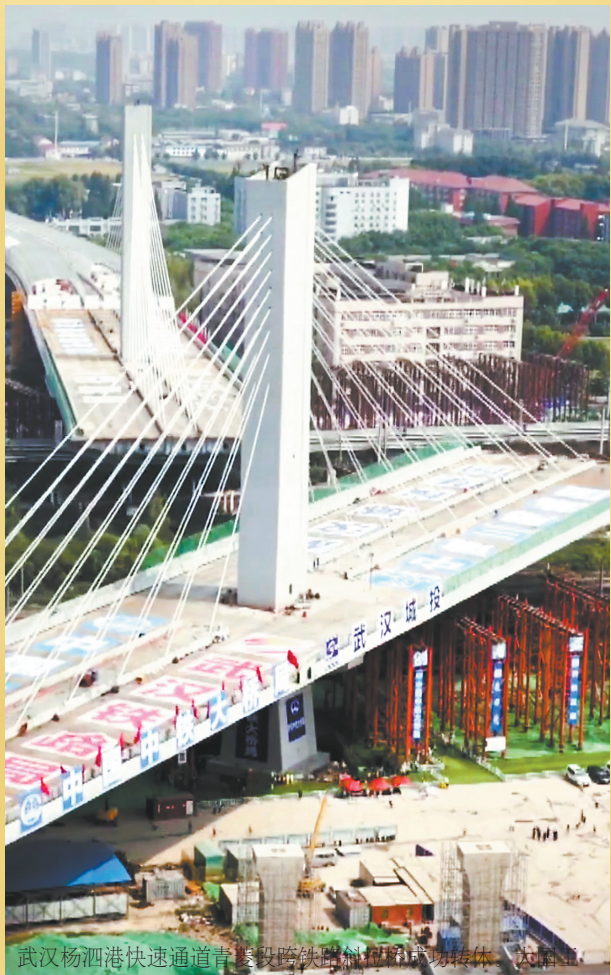
武汉杨泗港快速通道青菱段跨铁路斜拉桥成功转体,每一帧画面都超燃!(详见工人日报客户端、抖音号)
