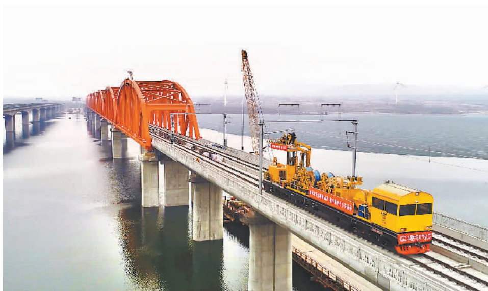
▲2019年6月8日，一辆施工作业车正在京张高铁官厅水库特大桥上架设最后一段1381.6米的接触网导线。 李忠民 摄/中铁电气化局 供图
