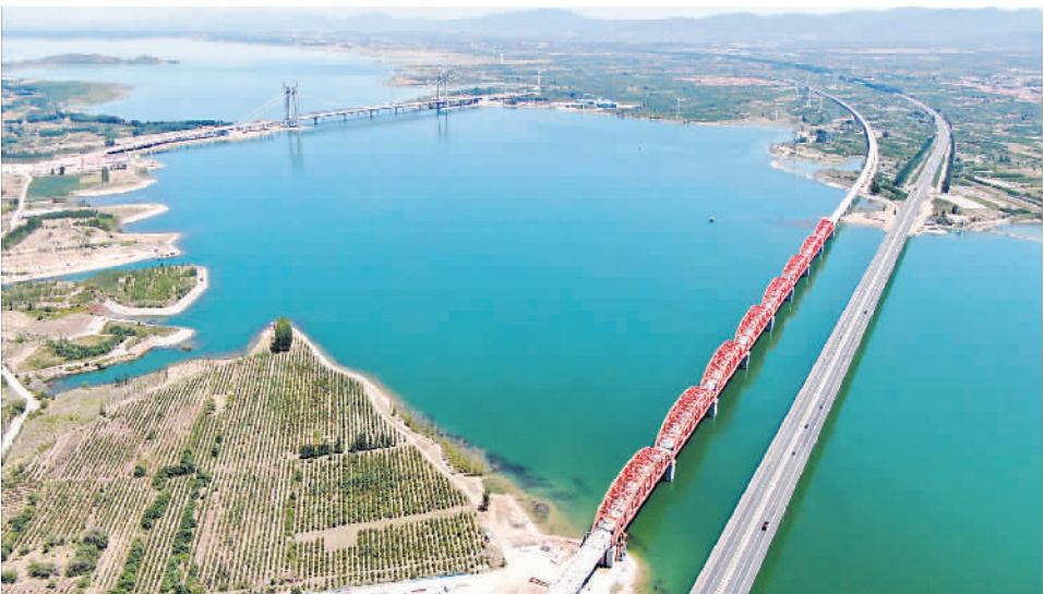
▲2017年11月11日，京张高铁官厅水库特大桥主体工程完工，全长9077米，是国内首例适用于350公里时速有砟轨道高速铁路的钢桁梁铁路桥。 本报记者 吴凡/摄
