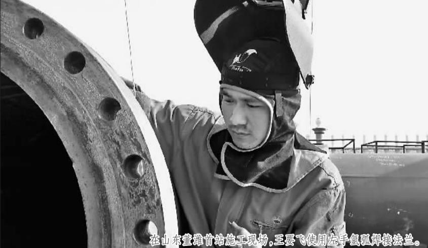
在山东鲁班首站施工现场,王要飞使用左手氩弧焊法兰。
