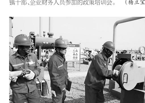
近日，中石化西北油田油气运销部塔河集气总站至拉依木门站67公里天然气管线运行状态下顺利实现清管作业，促进了天然气管网安全、高效、平稳运行，同时也提高了天然气气质。为确保作业顺利，清管前油气运销部从安全、环保、技术保障等方面进行了精心准备。图为清管作业人员正在把清管器往发球筒内安放。
