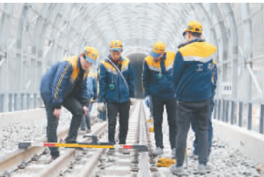
杨东升正在使用道尺检查线路几何尺寸
