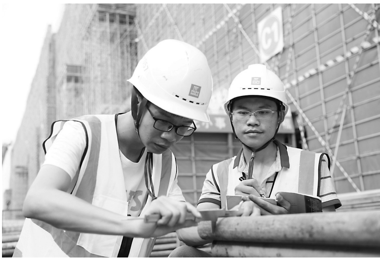
朱亮(左)与石国强在施工现场测量钢管直径。
