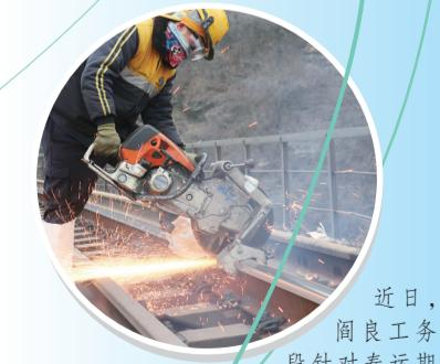
近日，韶关工务段针对春运期间车流量大、安全责任重大的实际，通过卡控安全关键、强化隐患排查、加大设备整修等措施，全力确保春运期间运输安全平稳有序。图为该段职工正在进行切割钢轨作业。（刘晓瑞 摄）
