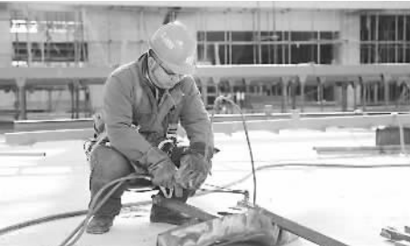
▲电焊工李井兵正在切割方管。
