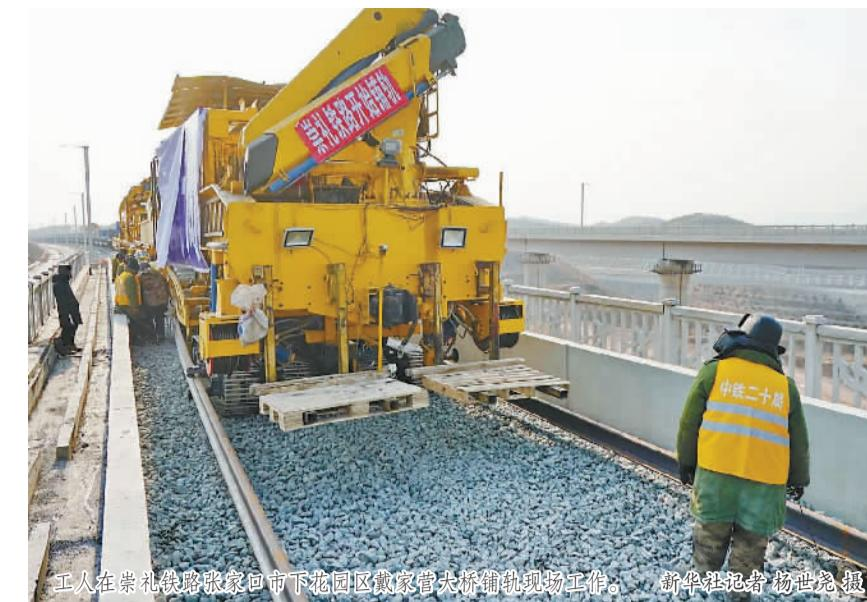
工人在崇礼铁路张家口市下花园区张家口大桥铺轨施工现场工作。新华社记者杨世光摄
