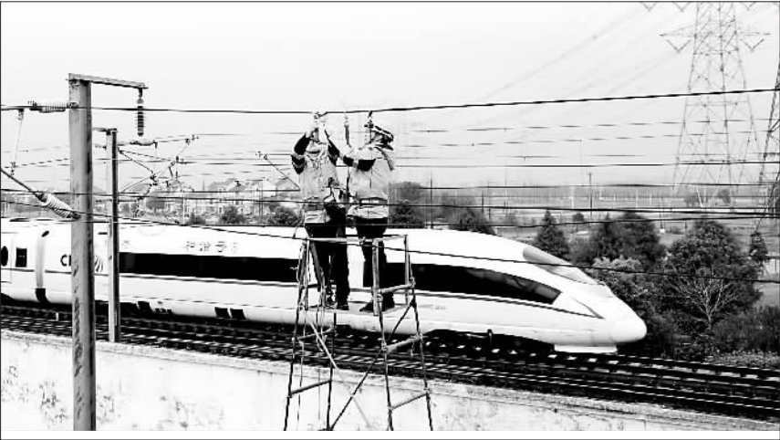
1月6日，一场高铁维修技能演练活动在中国铁路上海局集团有限公司金山北综合维修工区内举行。活动上，高铁维修工展开了轨道修复、接触网保障、电路维护和检测车辆保障等业务演练。图为高铁维修工练习接触网吊弦更换。
