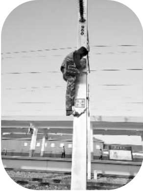
2018年12月20日,中铁武汉电气化局的接触网工在哈牡客专尚志南站安装支柱标志牌。 王林 摄
