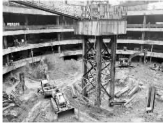
2017年,基坑作业用上了挖掘机,施工效率是原先人力挖土的好几倍。 刘小丰 摄
