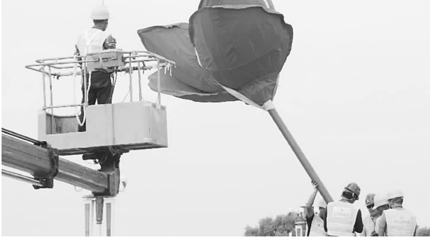
北京:工人安装巨型花篮
