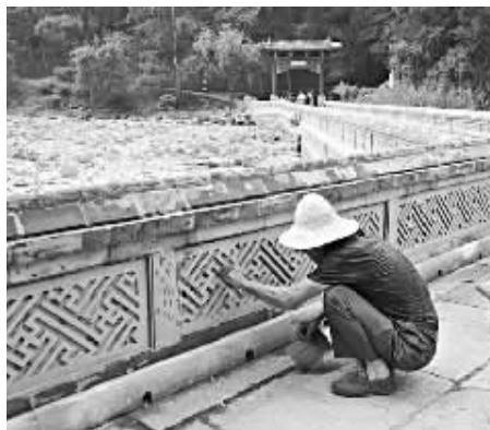
周东升蹲在桥面的护栏旁打磨沙眼。
