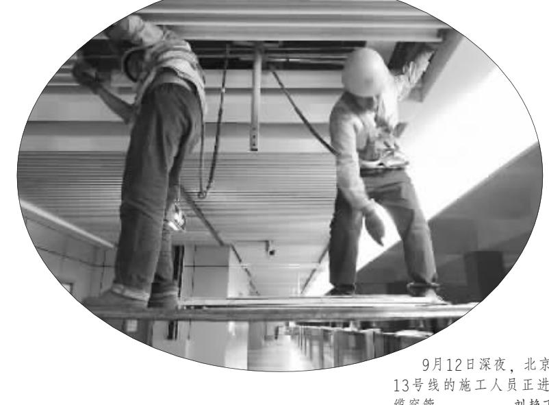
9月12日深夜，北京地铁13号线的施工人员正进行线缆穿管。 刘艳飞 摄
