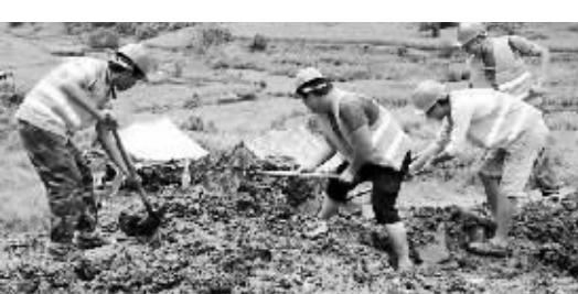
7月30日20时40分，成昆铁路阿塞至白果K346+900区间内，突发泥石流灾害，上万方泥石掩埋铁道线。40多名农民工全力以赴投入到抢险工作中。
