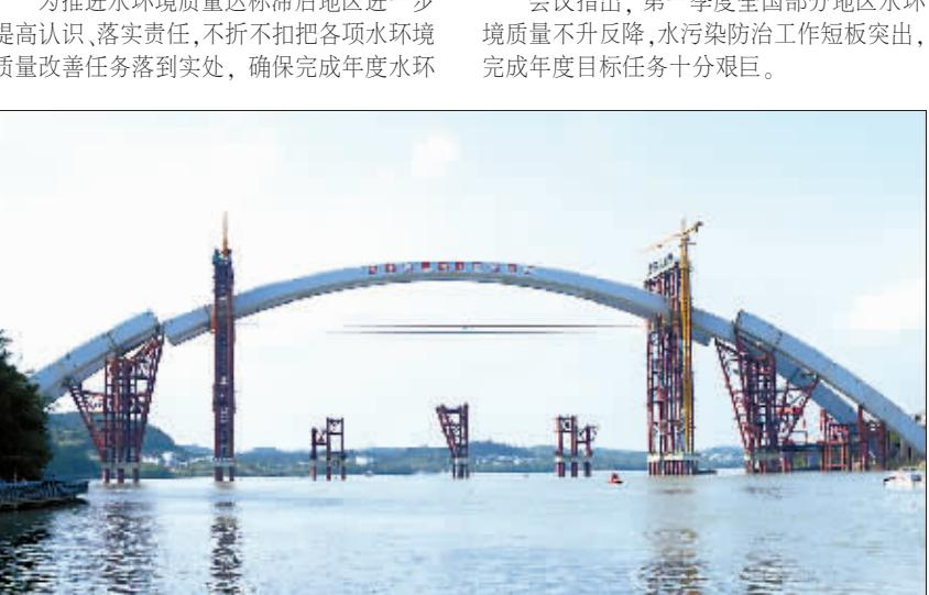
5 月 14 日凌晨,在广西柳州柳江上,跨度达 457 米的世界第一大有推力钢箱梁拱桥——柳州官塘大桥的 5885 吨主拱段整体提升到位。据介绍,此次提升创下了整体提升高度、整体提升重量、提升拱肋跨径三项“世
