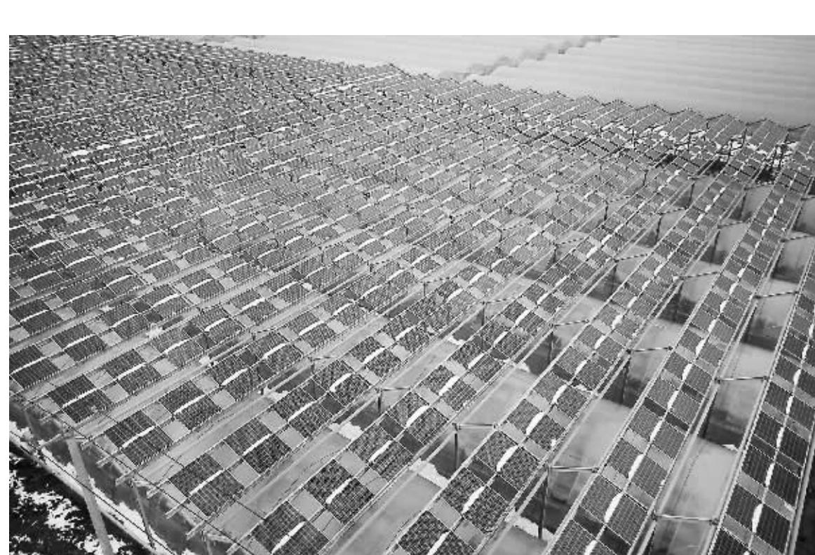
图为1月28日航拍的江苏省南通市首个光伏生态农业大棚示范项目。该生态农业光伏大棚示范项目装机容量814.2KW,在占地约1.2万平方米的农田内架设4.855米高的钢结构,顶部安装2760块295wp的单晶硅光伏组件,共覆盖18个蔬菜大棚。项目建成后年光伏发电量约100万千瓦时,每年可节省标煤320吨。光伏大棚融入传统农业,不仅可以获取高效农业、绿色发电等经济效益,也实现了节能减排的社会效益。
