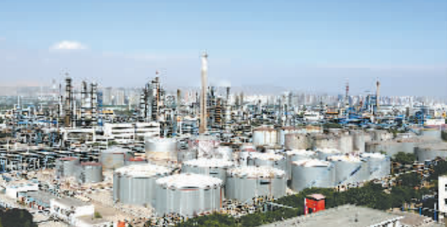
兰州石化炼油装置一角
