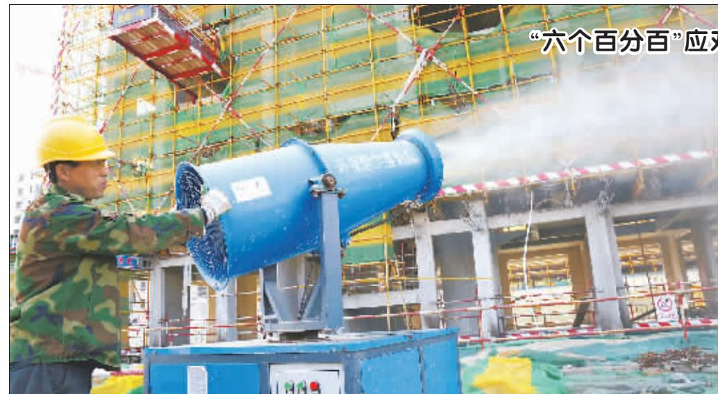
11月5日,在山东省滨州市博兴县一处建筑工地,一名建筑工人操作“环保除尘雾炮机”降低施工扬尘污染。
