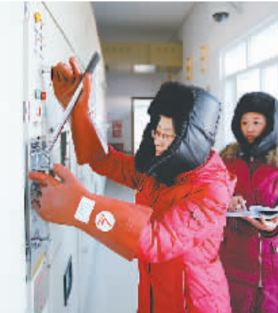
在66千伏城郊变电站手把手教员工进行倒闸操作
