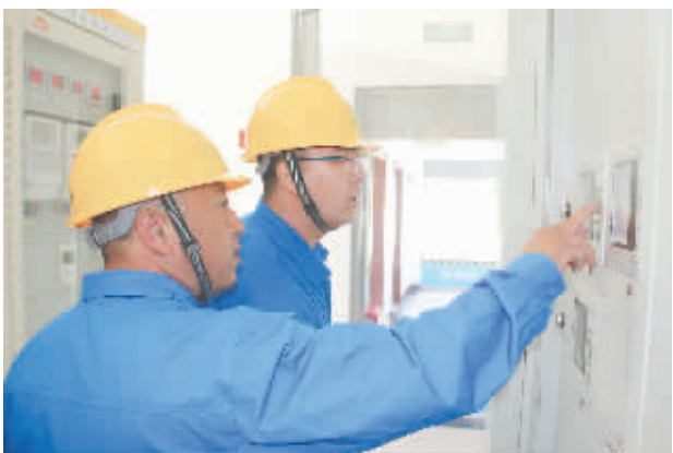
检查公用测控屏母线电压情况
