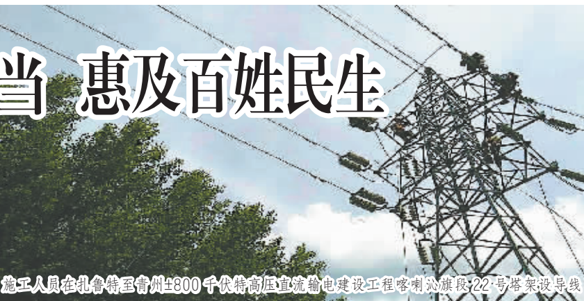
施工人员在扎鲁特至青州±800千伏特高压直流输电建设工程喀喇沁旗段22号塔架设导线
