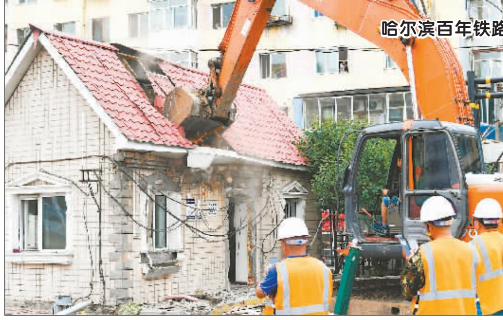
8月23日,工作人员操作工程车辆拆除哈尔滨市滨绥线3KM041M铁路道口房。未来,这里将建设下穿滨绥铁路的新型双向多车道隧道桥。
