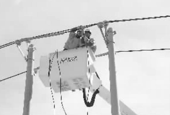
开展带电作业方式，确保不间断供电
