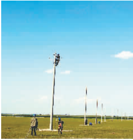
为机井通电工程立杆架线
