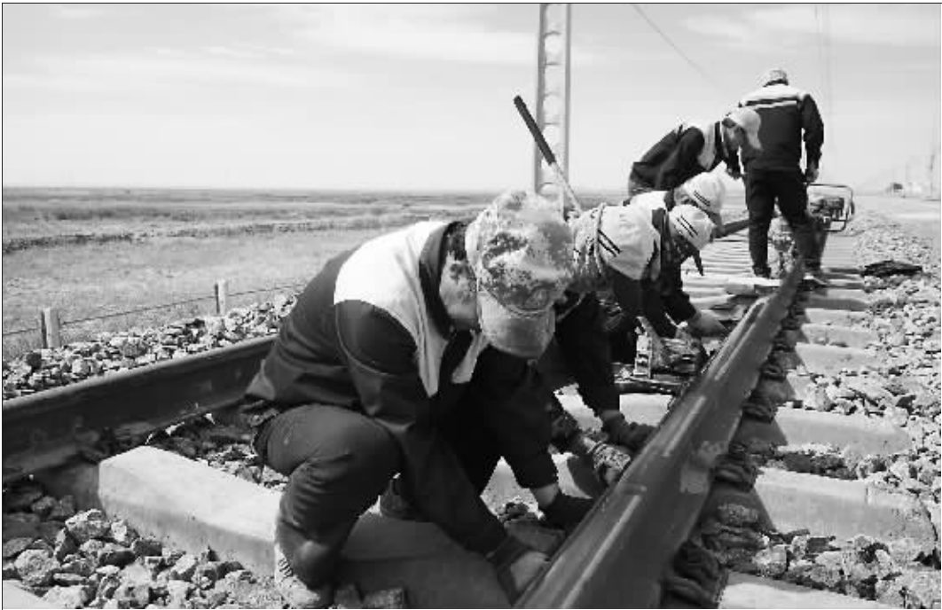
“天路”上的坚守 青藏铁路公司格尔木工务段保养组工作人员在检修检修组发现的轨道水平问题(7月7日摄)。 青藏铁路全程1900多公里,其中海拔4000米以上路段约960公里。不管高寒酷暑、风霜雨雪,铁路的运行不停歇,铁路的养护工作也丝毫不能松懈。 新华社记者 冀泽 摄
