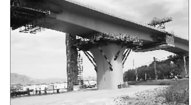
6月14日15时30分，中铁三局集团公司承建的京张铁路新保安高架特大桥与京包铁路两侧的主桥精准对接、成功合龙，成为京张铁路完成转体施工的首座特大桥。
