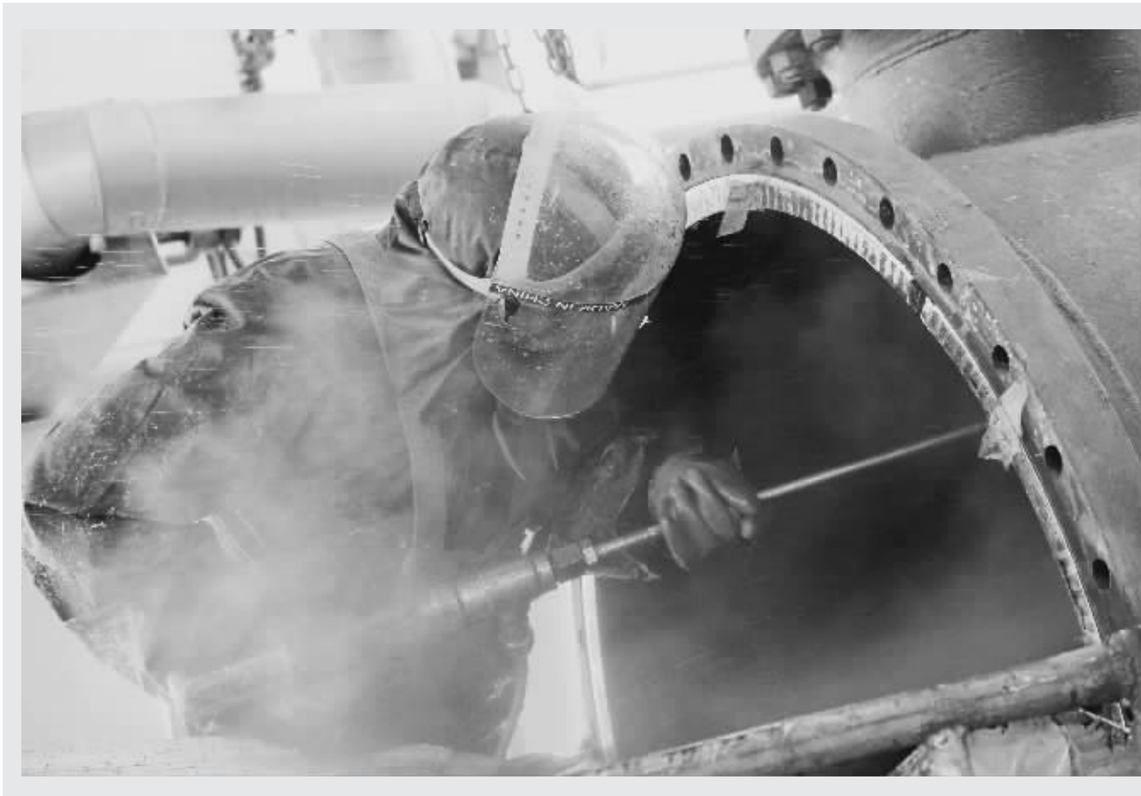
5月9日,吉林石化公司借苯酚丙酮装置短停检修时机,对E-619汽提塔冷凝器进行消缺查漏检修。身穿绿色全封闭防护服的检修人员在水雾中连续作业6小时,共计清洗管束233根,215平方米,冷凝器换热能力大幅提升。 图为施工人员用高压水枪进行打压清洗。 车玉花 摄
