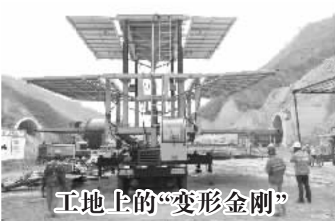
这台名为“自移动液压式多功能作业台架”的设备,被一线工人形象地称作“变形金刚”。这是中铁隧道集团蒙华铁路9标二工区员工李军和团队为满足预切槽试验而研发的一种可以灵活调节身高、臂长、体积的设备。
