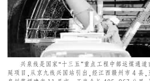
兴泉线是国家“十三五”重点工程中部运煤通道南延项目，从京九线兴国站引出，经江西赣州市4县，至泉州等福建省11县市，正线全长495.867公里，计划工期4.5年。图为中铁十一局兴泉项目部峰果岭隧道工人在用雾炮技术养护二衬混凝土。(潘涛 陈海摄)
