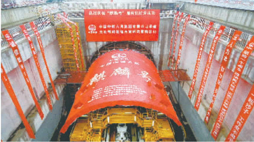
中铁六局和中铁装备自主研发,中铁六局组织,目前在施的我国最大直径(Φ12.14m)土压平衡盾构机“麒麟号”在太原西南环线铁路工程始发
