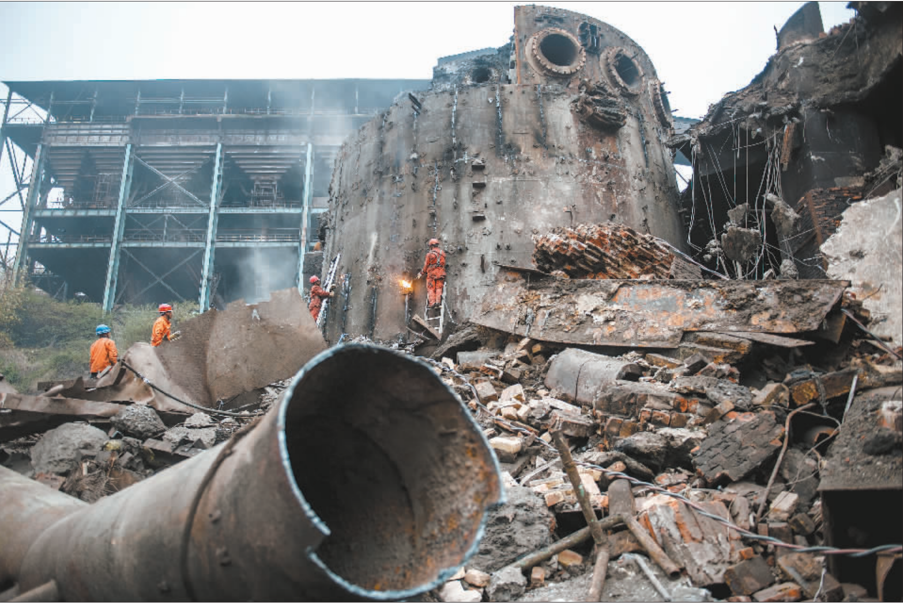
工人们正在对水钢2号高炉底座进行拆除。这座高炉在1978年建成后,进行过四次原样大修,如今即将消失在人们的视野中。
