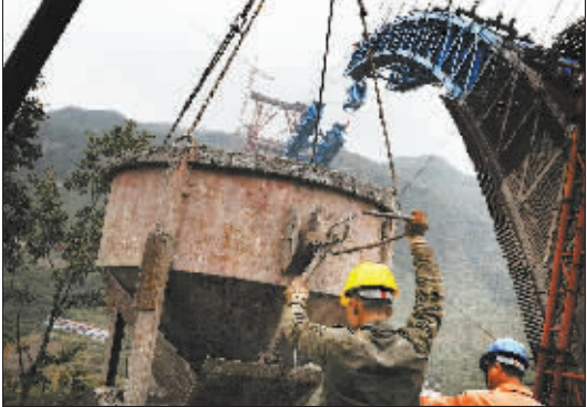
因混凝土施工的特殊要求,浇注桥墩的工作必须日夜不停。
