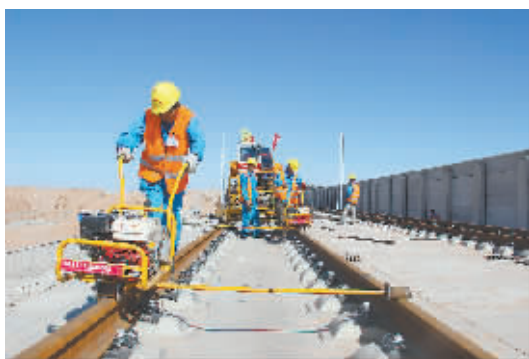
长轨铺设后紧固扣件
