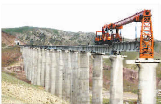
架设精伊霍伊犁河谷第四座特大桥——尼勒克特大桥
