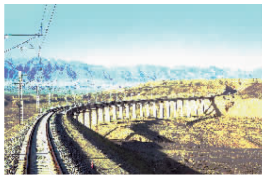
新疆第一条电气化铁路——精伊霍铁路
