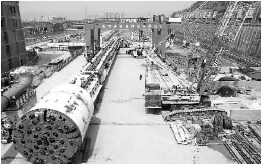
正在现场组装的单护盾TBM
