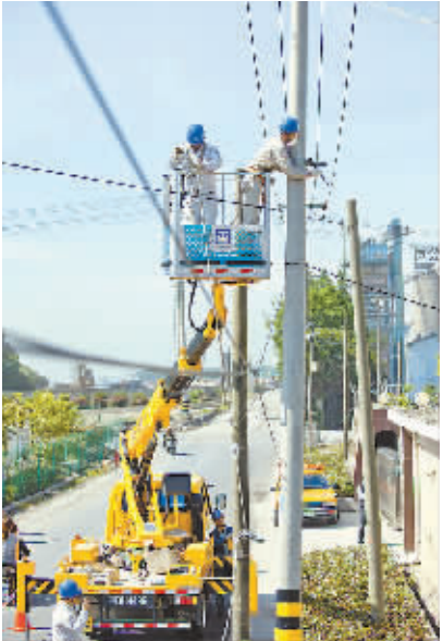
长兴供电公司 为海塘所抢修移动因附近施工造成裂缝的电杆
