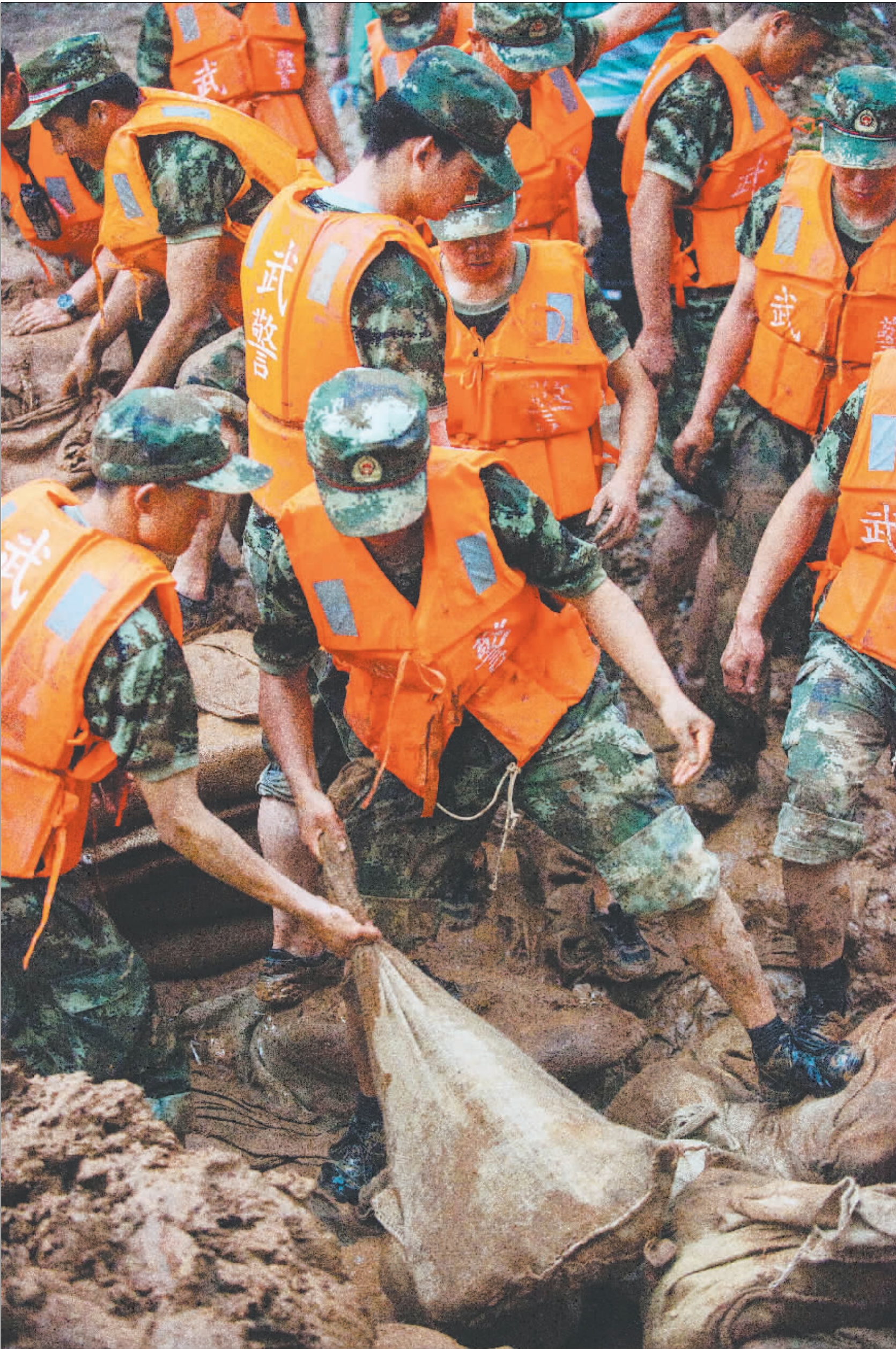
7月7日,武警南京支队的官兵正在南京树人中学背后的长江大堤上加固大坝,防止新一轮的降水造成江水倒灌。
