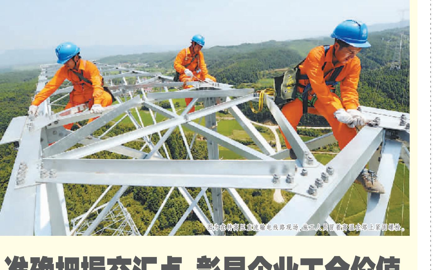
图为在渝高高压直流输电线路现场,施工人员冒着高温在塔上紧固螺栓。
