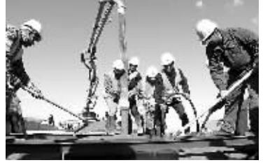
近日，中国中铁四局承建的八棱观特大桥在全线率先开始底座板浇筑，标志着京沈高速铁路客运专线无砟轨道施工正式开始。京沈客专设计时速350公里，全线轨道板采用的是具有我国自主知识产权的Ⅲ型板。其中，中国中铁四局承担着京沈客专辽宁段42.43公里建设任务，涉及无砟轨道施工84.86公里。
