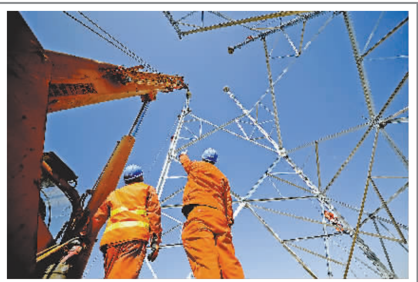
陕西首条1000千伏特高压线路组立铁塔
